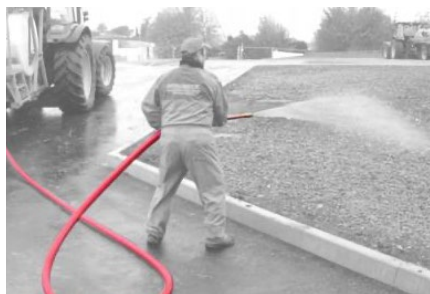
Slang Ø52 Aansluiting Storz-koppeling.
